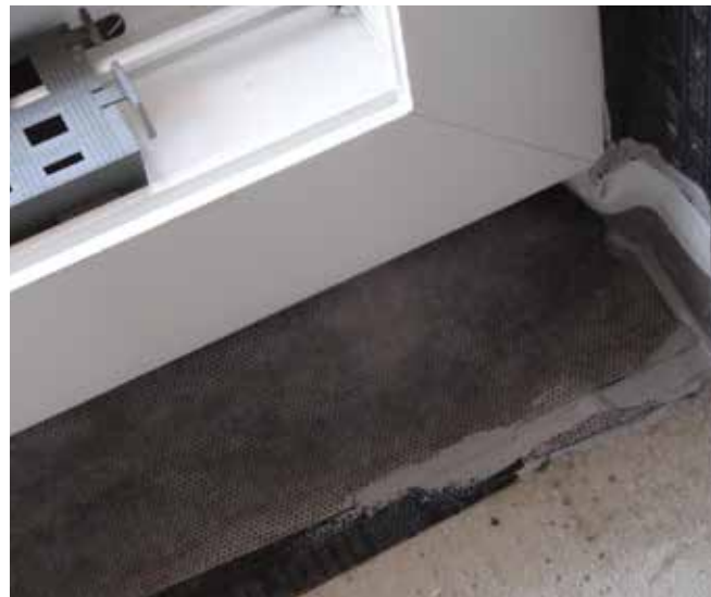
Slika 4: Prikaz namestitve tesnilne folije na notranji strani.
