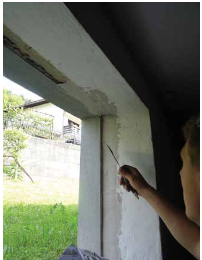
Slika 2: Priprava odprtine za vgradnjo: trdna, ravna in brez nečistoč.
