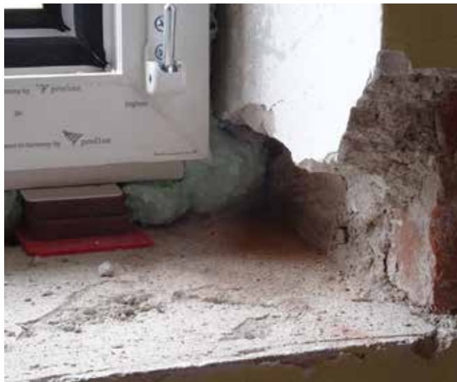
Slika 3: Desno so prikazane trajne podložke in montažna pena, ki služi kot toplotna in zvočna zaščita.
