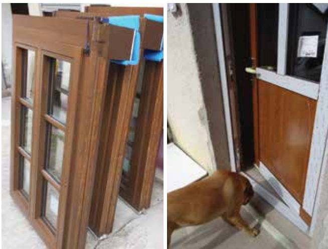
Slika 1: Okna in vrata izbiramo glede na njihove lastnosti in tehnično-tehnološke rešitve – levo okno iz lesa, desno vhodna vrata iz PVC.
